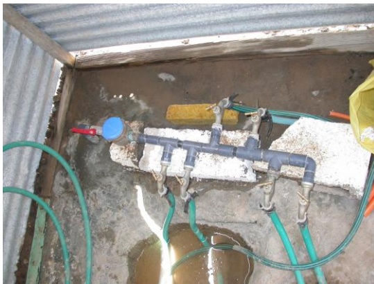
Figure 4 a, b Point de distribution privé (BF privées) avec compteur et tuyaux plastiques
