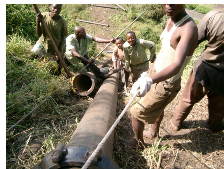
Pose de la canalisation sur la pente et du tronçon à partir de la station du lac Kivu
