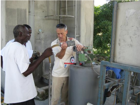
Récupération d'un ancien bac à chlore
